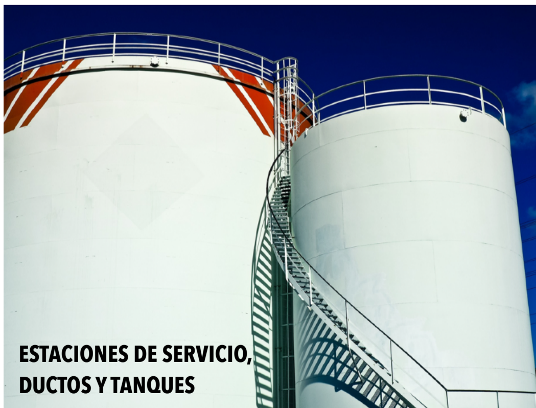
TERMINALES DE ALMACENAMIENTO Y PROCESO
